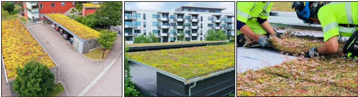
Figur 12. Exempel på gröna tak (sedumtak). Foto: Vegtech
